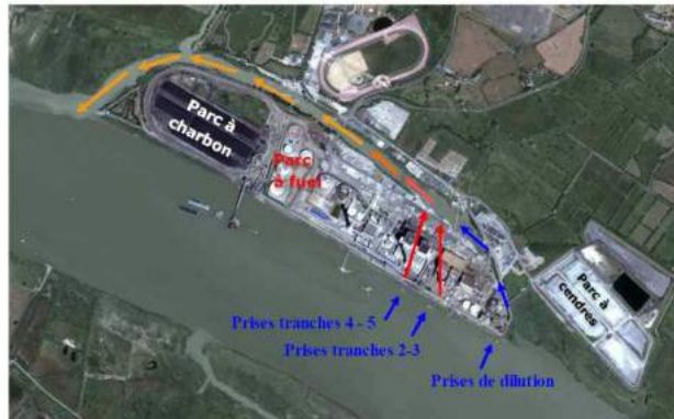
L'UP de Cordemais prélève l'eau directement en Loire (flèches bleues). L'eau réchauffée (flèches rouges) est rejetée dans le bras de Cordemais où elles se mélangent avec l'eau déjà présente dans le bras (flèches orange).
